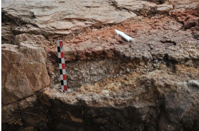
fig. 3 Détail du mortier à base de quartz grossièrement pilé (cliché N. Albinet).
