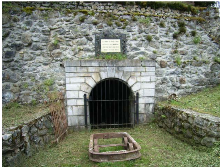
Sem – Entrée de la galerie Becquey de la mine du Rancié
