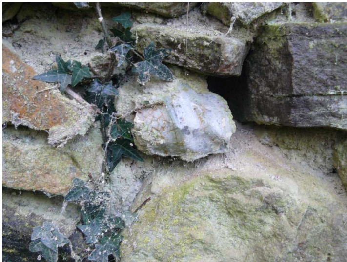
Pierre vernissée dans le mur de la grange
