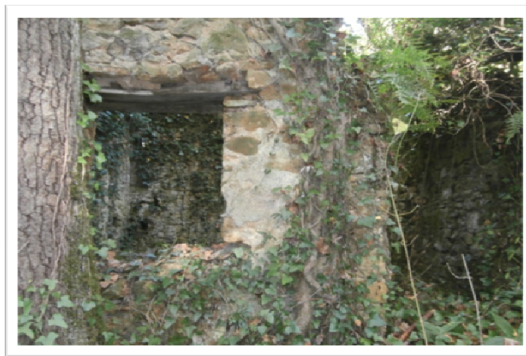
Façade sud du 1 er bâtiment
